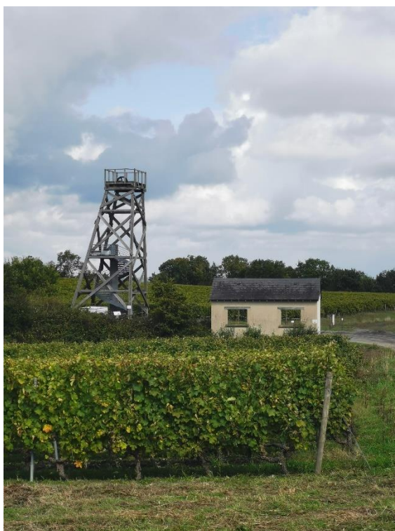
Photo 21 : La mine et le chevalement des Malécots à Chaudefonds-sur-Layon – GAMA Environnement
