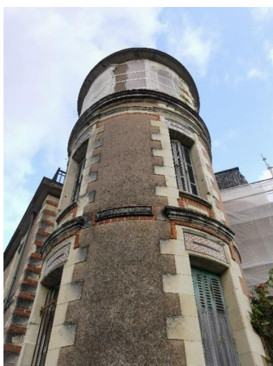
Photo 18 : Bâti de caractère en cours de restauration dans le cœur de bourg à Chaudefonds-sur-Layon - GAMA Environnement
