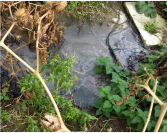
Débordement d'une fosse (danger pour la santé des personnes et pollution)
